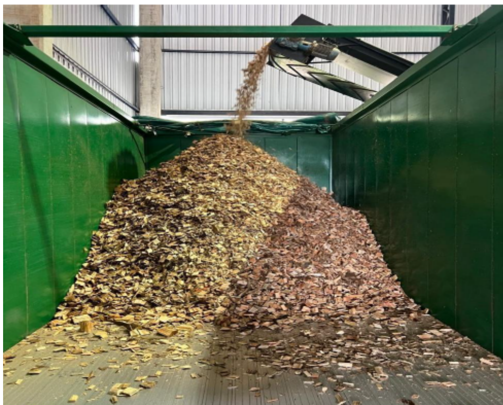
Figura 48 – Picador conduzindo cavaco para depósito
