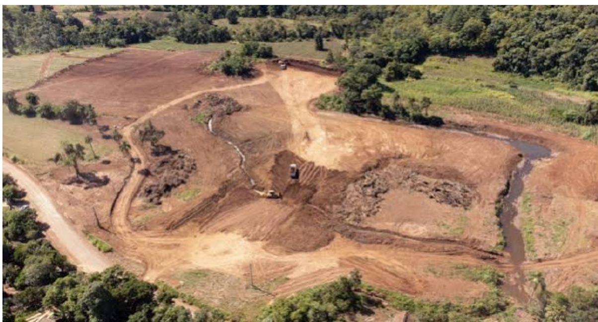
Figura 59 – Imagem aérea dos serviços de terraplanagem
