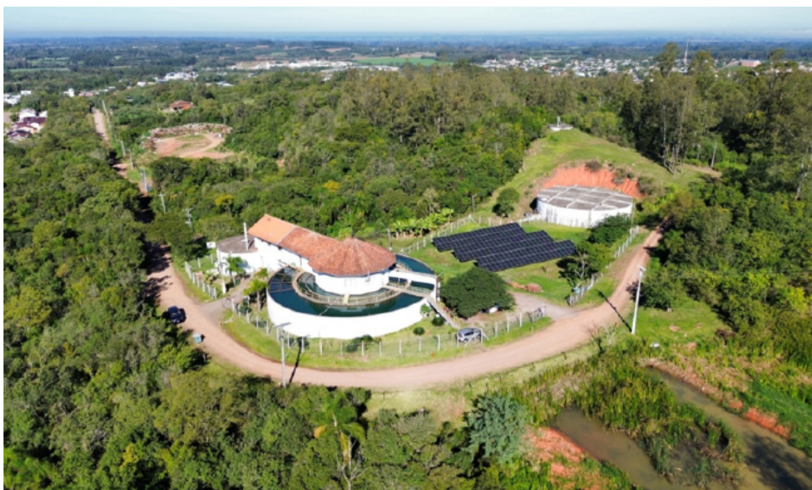
Figura 67 – Vista aérea da ETA e da ampliação
