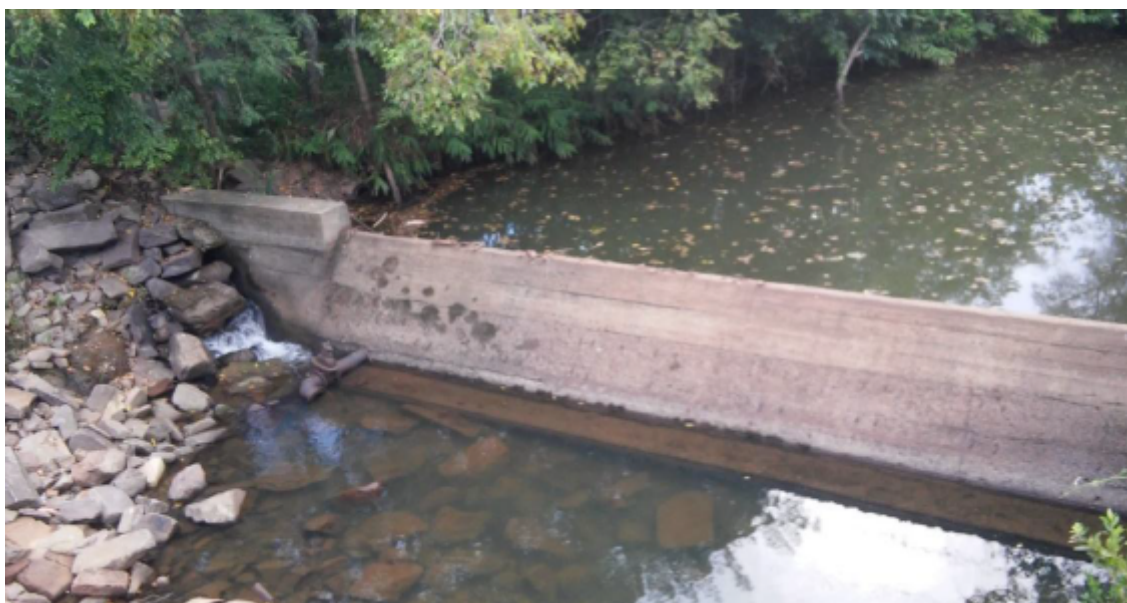
Figura 68 – Ponto de captação no Arroio Andreas
