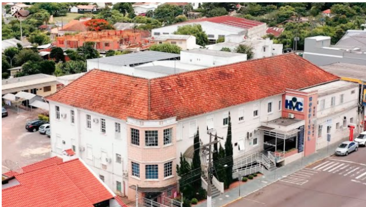
Figura 30 – Imagem da estrutura atual do Hospital Vera Cruz (2025)
