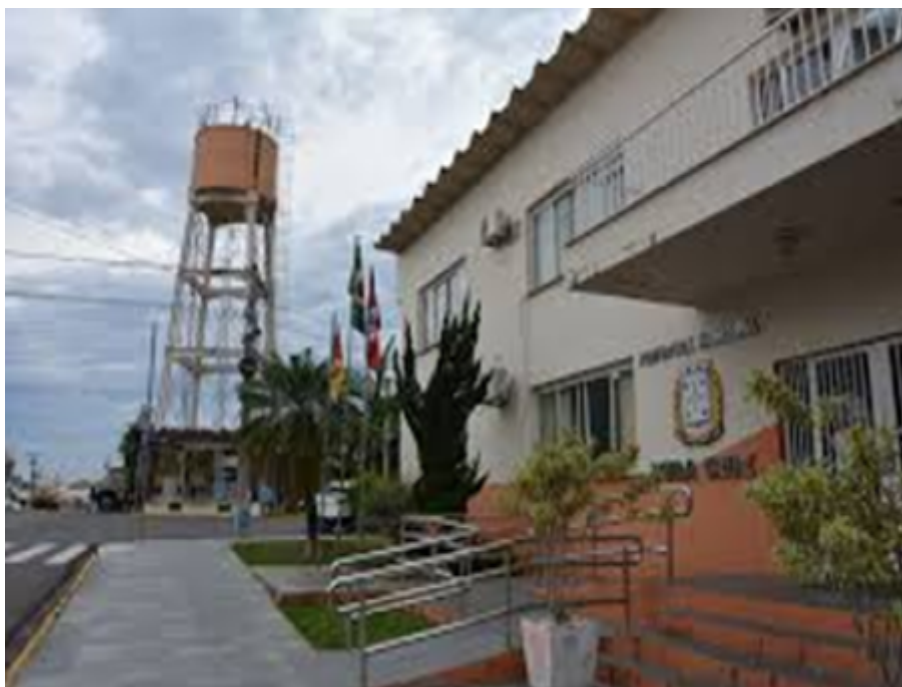
Figura 63 – Imagem da caixa d'água no centro urbano de Vera Cruz
